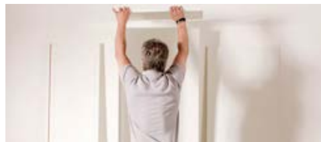
Bovenkant plaatsen en naar de zijkant van het meubel schuiven.
