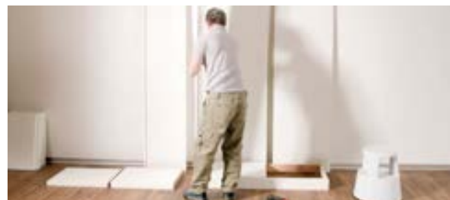
Zijkant van meubel op de sokkel plaatsen. Door de uitstekende schroef staat het element meteen in de juiste stand.
