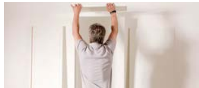
Deckel aufsetzen und zur Möbelseite schieben.
